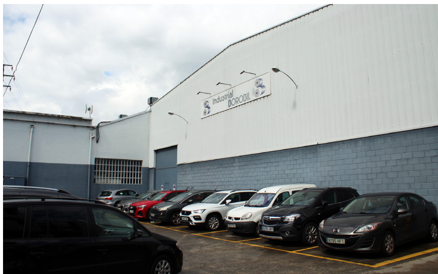
Exterior de las instalaciones de Industrial Borobil en Billabona (Guipúzcoa).
